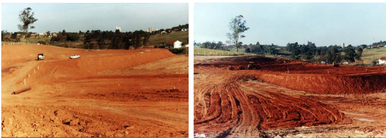
Figura 6 – Detalhes da Construção da ETE Tibiriçá no Município de Garça - SP
