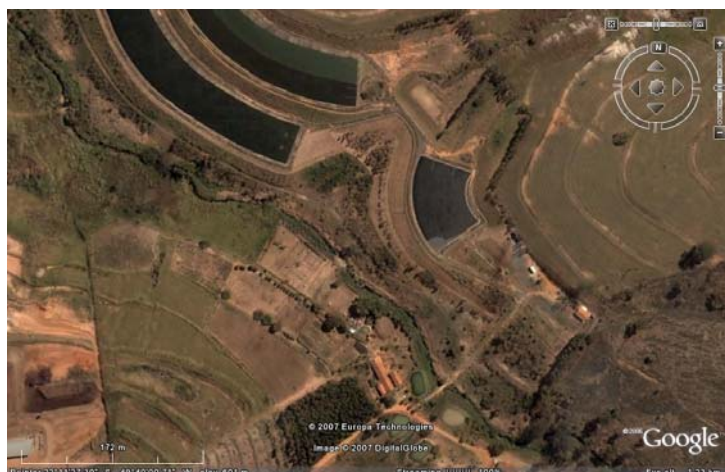
Figura 2 – Vista Panorâmica da ETE (Estação de Tratamento de Esgoto) Tibiriçá.
