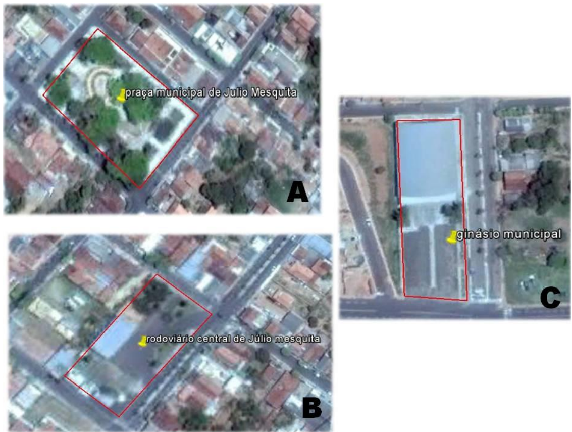
Figura 02. Vista aérea das áreas analisadas no município, sendo A= Praça Municipal Central; B= Rodoviária Municipal; e C= Ginásio municipal.
